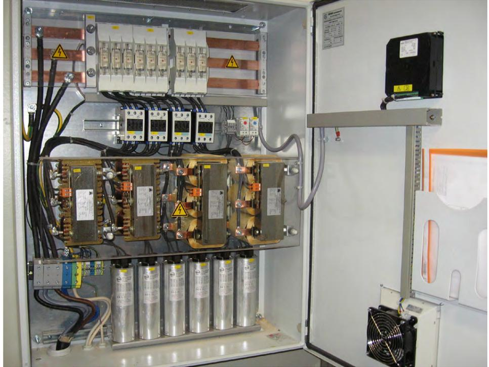
Figura 12. Ejemplo de un sistema de corrección del factor de potencia empleado para la corrección centralizada del factor de potencia. Observe los seis condensadores (dos por fase) situados en la parte inferior del sistema.
