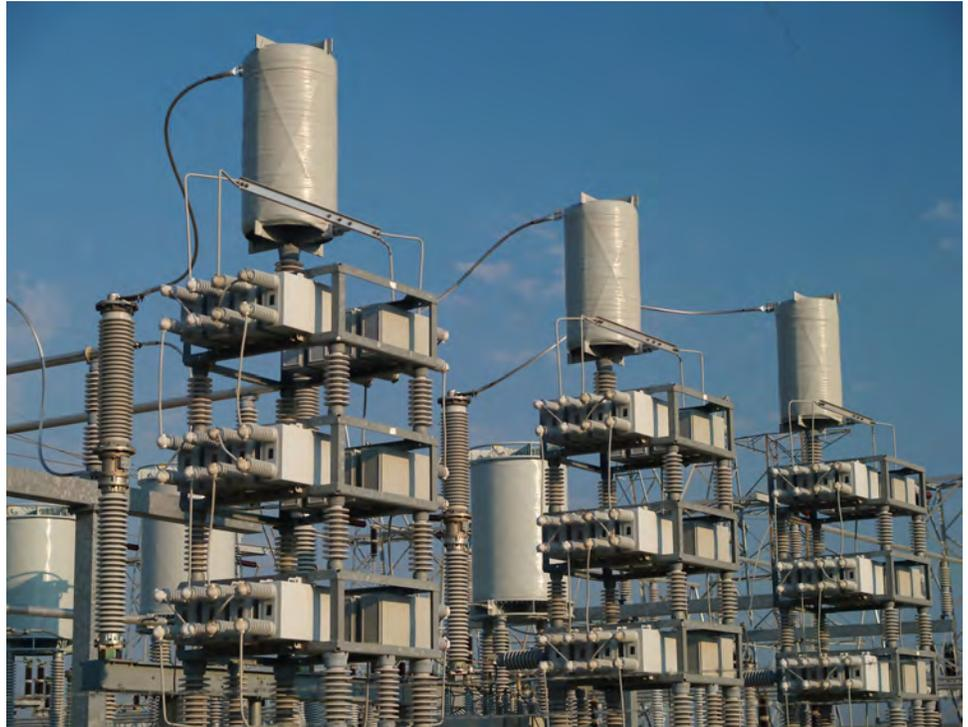
Figura 6. Batería de condensadores empleada para la corrección del factor de potencia.
